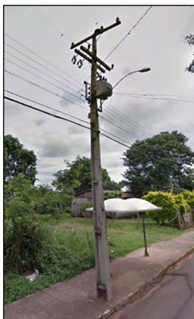
Figura 9 - Iluminação - Sistema 3 - VSAP 150W - Rua Rubens Feldens
