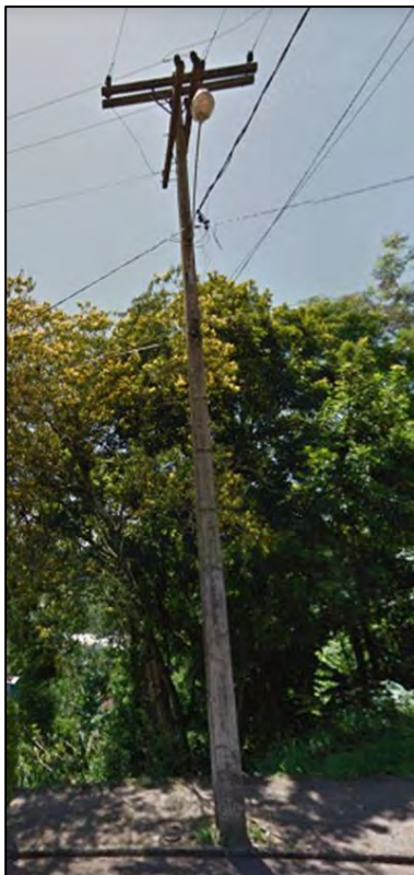
Figura 10 - Iluminação - Sistema 4 - VSAP 400W - Rua Santa Maria
