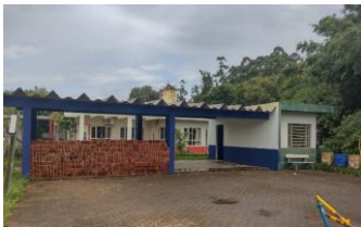
Fachada da edificação
